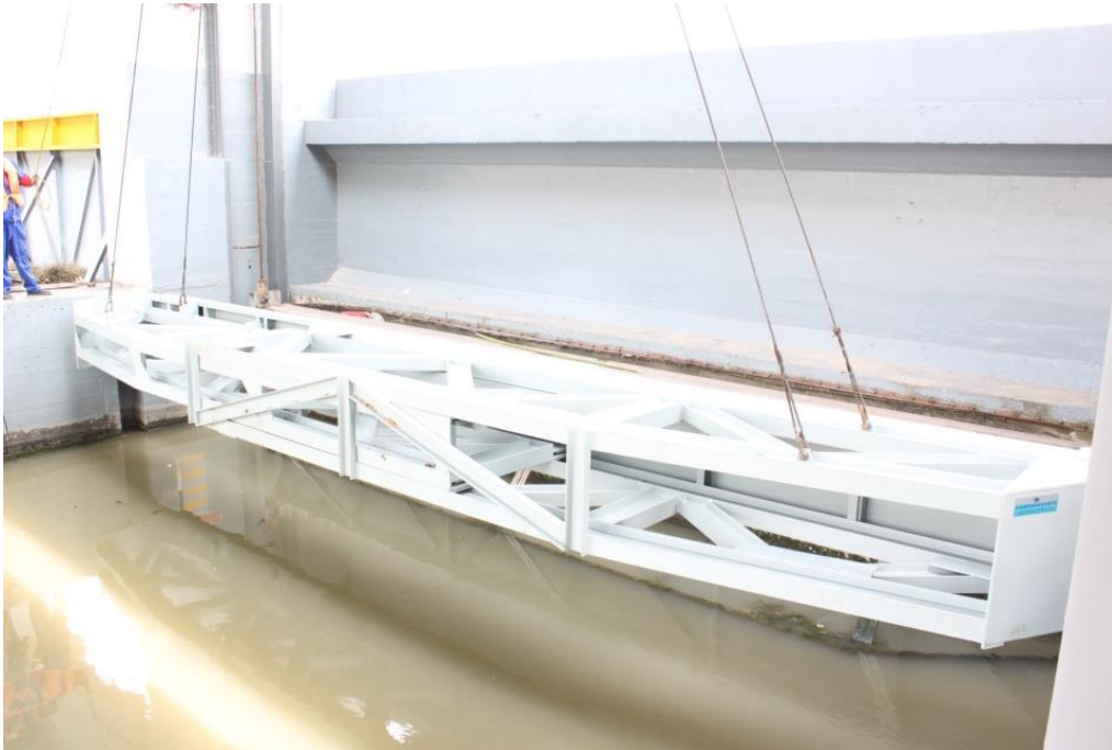
可变宽度叠梁式检修闸图例
