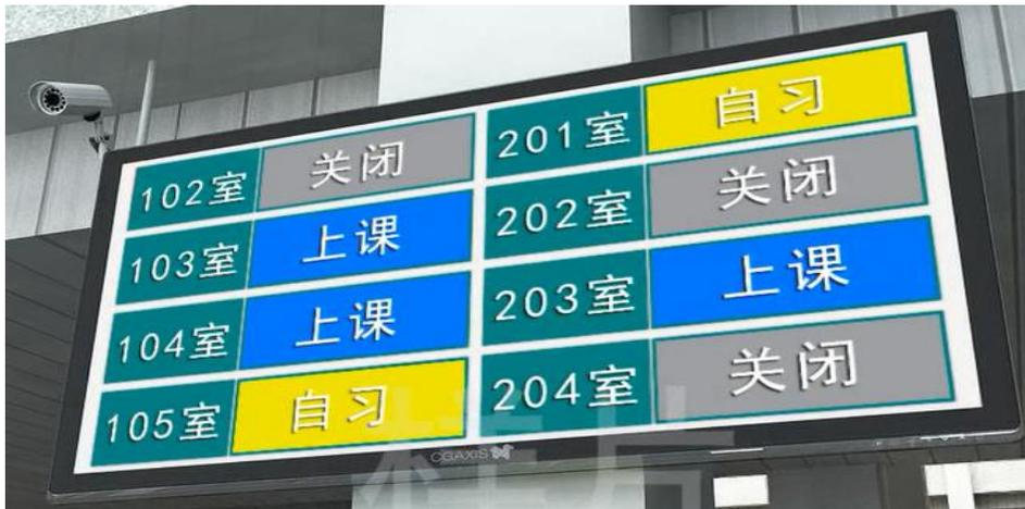
节能控制系统在楼栋大门处设置显示屏，将楼内各项信息显示出来，方便师生员工在进入大门时就对楼内各项情况有所了解。
