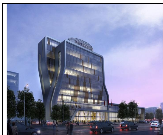
青海夏都医药公司综合办公楼
