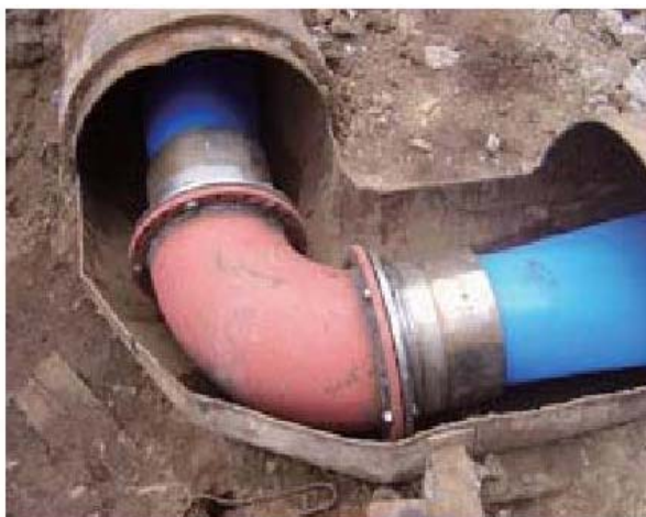
pipe-in-liner 非开挖管道修复技术现场施工
