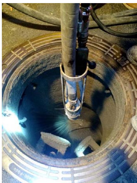
CCM 离心喷涂施工
