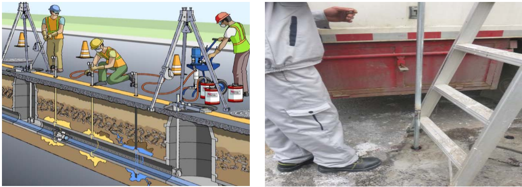
管道内注浆堵水
