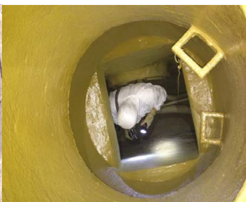
检查井修复后
