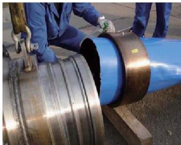
pipe-in-liner 非开挖管道修复技术现场施工
