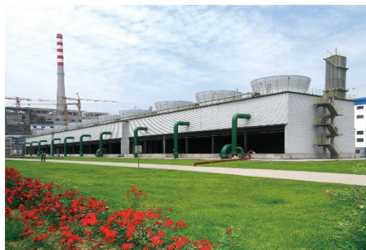
中国石油化工股份有限公司武汉分公司（湖北·武汉） 23 台 NH-5000 型冷却塔
