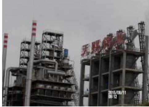
2015年7月16日，氧化钙二厂点火试生产。4座环保机械化竖窑，设计生产能力为日单产氧化钙100吨。
