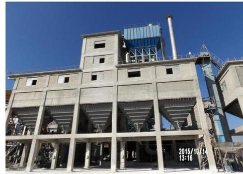
2015年10月20日，0~3细粉生产线试车成功。该生产线可将氧化钙磨成0~3mm细度，用于环保脱硫等。
