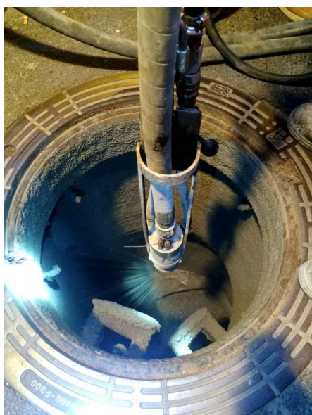
CCM 离心喷涂施工
