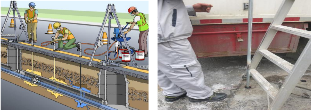
管道内注浆堵水
