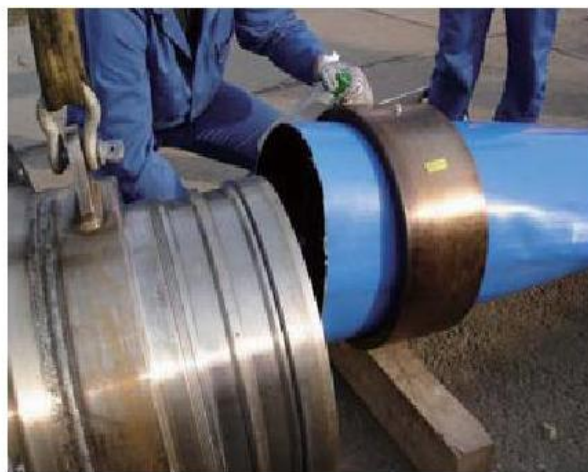
pipe-in-liner 非开挖管道修复技术现场施工
