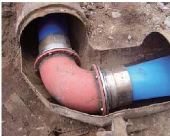
pipe-in-liner 非开挖管道修复技术现场施工
