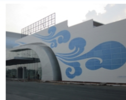
景德镇机场航站楼
