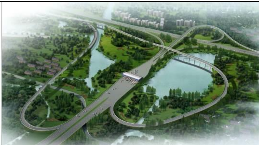
沪宁高速园区快速连接线工程
