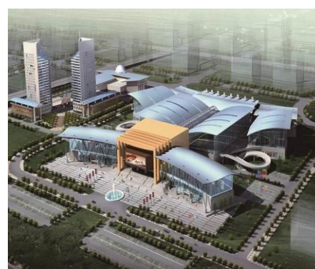
包头国际会议中心金属屋面系统
