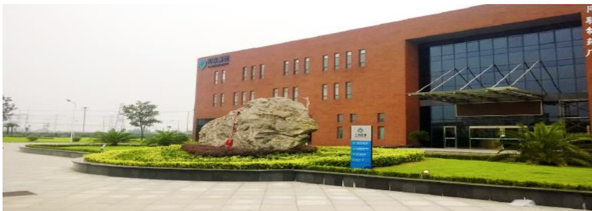
同联制药厂景观施工实景
