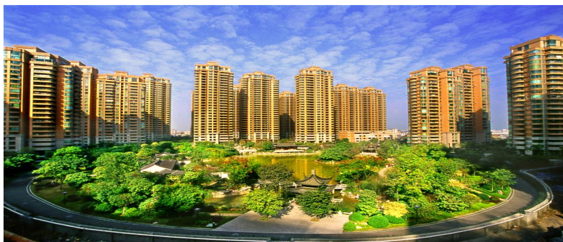
佛山南海颐景园项目实景
