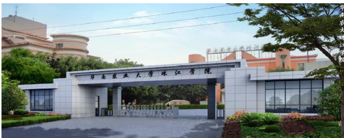
华南农业大学珠江学院景观施工实景
