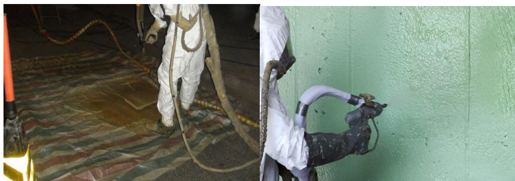
喷涂样板表面喷涂
