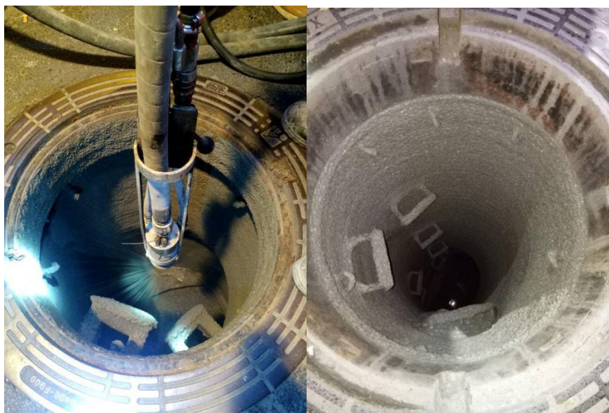
CCM 离心喷涂施工
