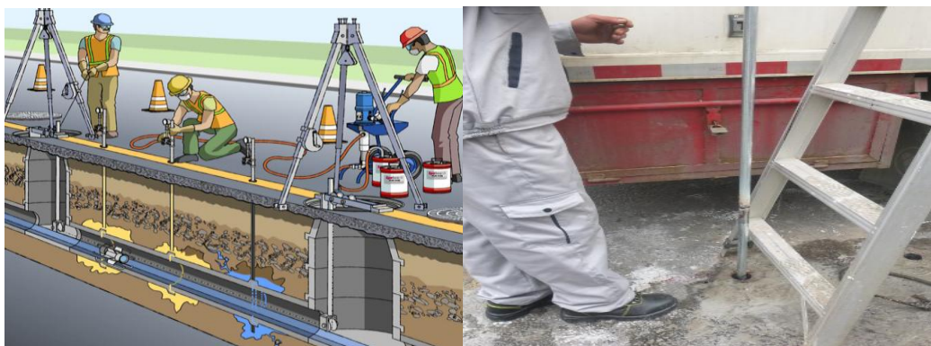
管道内注浆堵水
