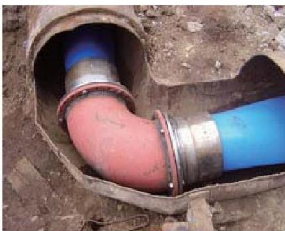
pipe-in-liner 非开挖管道修复技术现场施工
