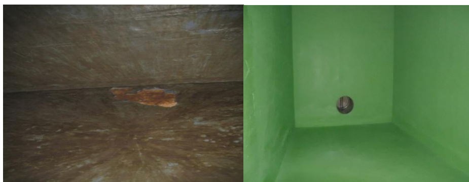
水池修复前水池修复后
