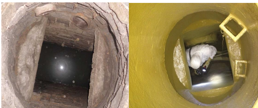
检查井修复前检查井修复后
