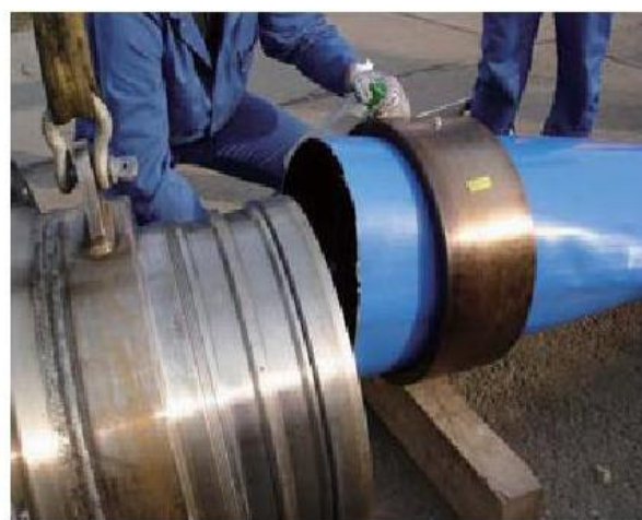
pipe-in-liner 非开挖管道修复技术现场施工
