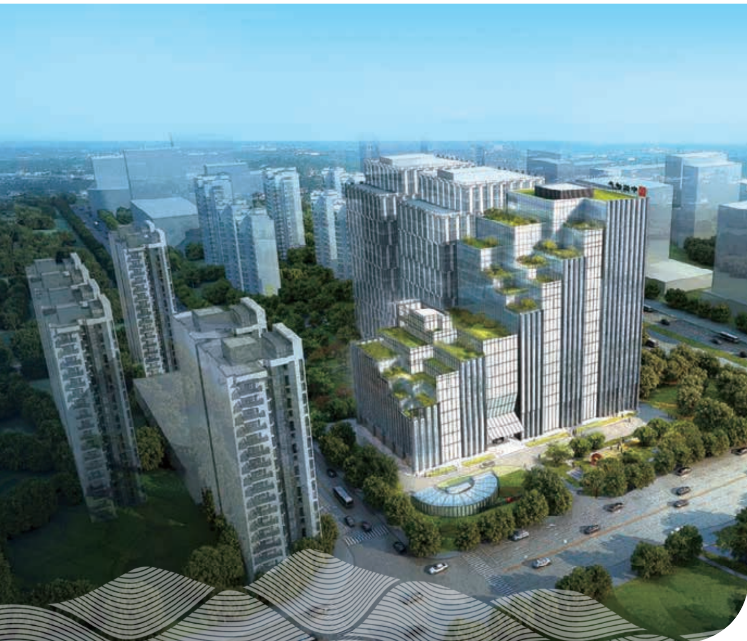
▲ 北京石景山區JA項目
