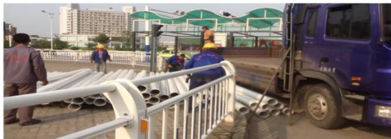
芜湖县政府大楼配电工程
