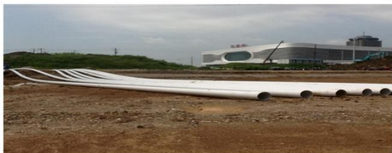
芜湖高铁站配电工程
