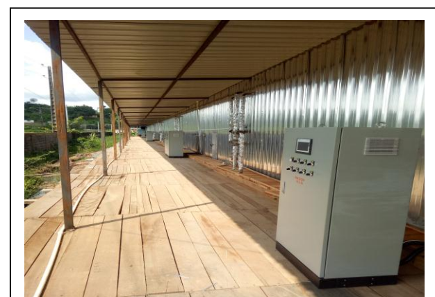
公司成功在国外（加蓬）施工的项目现场
