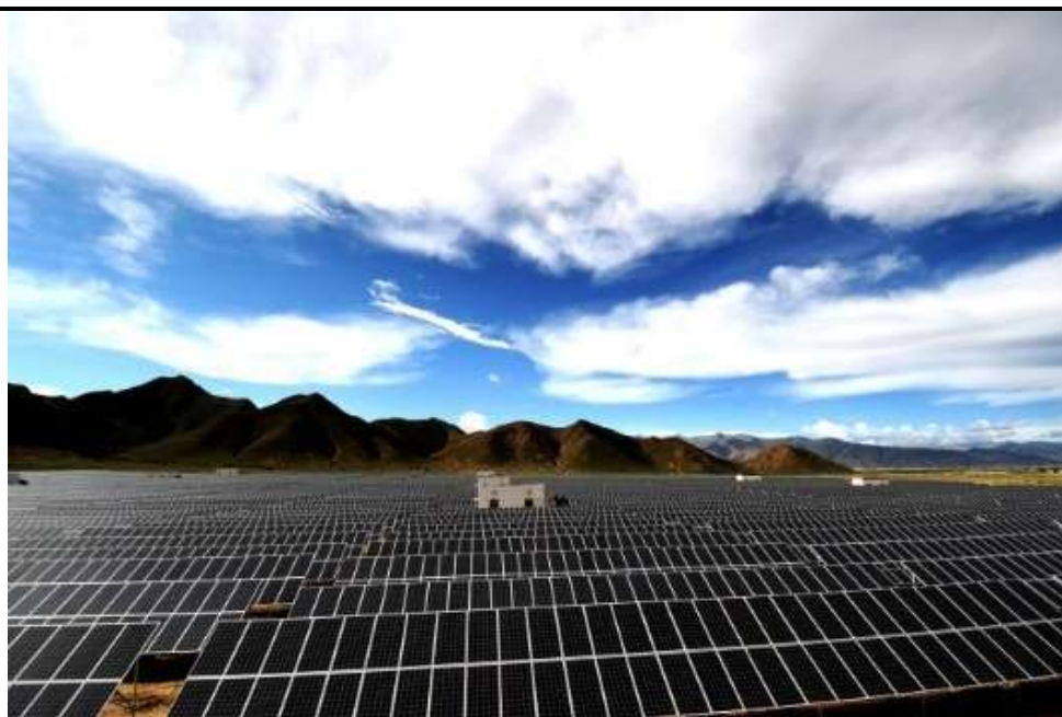
西藏日喀则 10MW 光伏 电站
