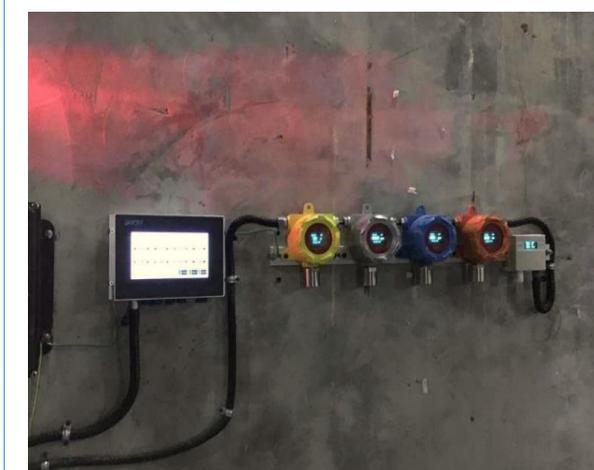
公司开发了环境监控系统，此系统包括监控主机和采集器，能把接收到的各类监测信息按主站系统要求的通信协议上传到局端主站系统。该系统可以广泛应用于城市综合管廊和电力隧道、地铁等城市地下空间的安全监测。
