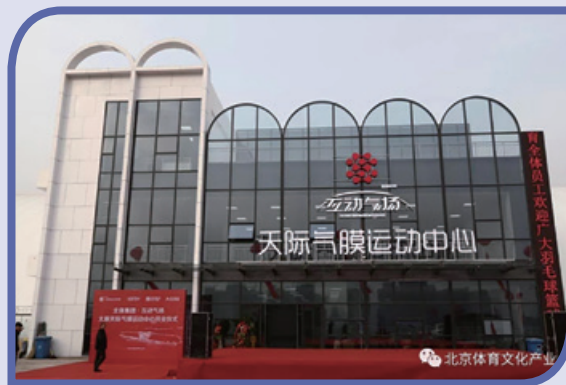
Tianji Air Dome Sports Center 天際氣膜運動中心系統
