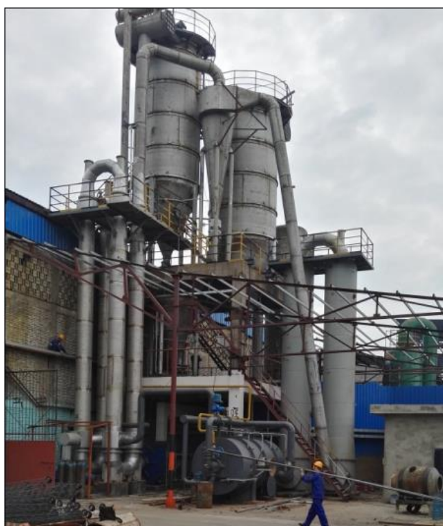
“三步法”熔炼炉项目主体工程顺利竣工
