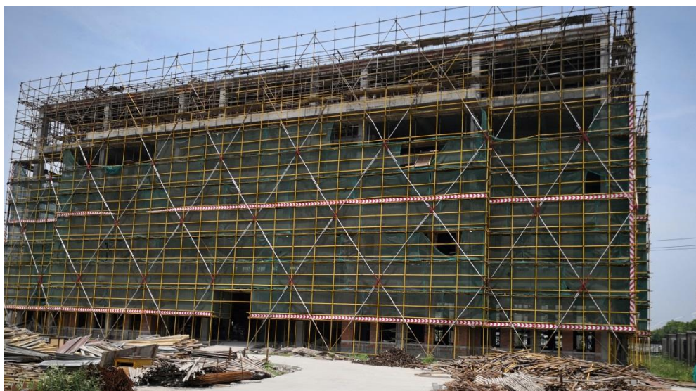
建设中的办公楼
