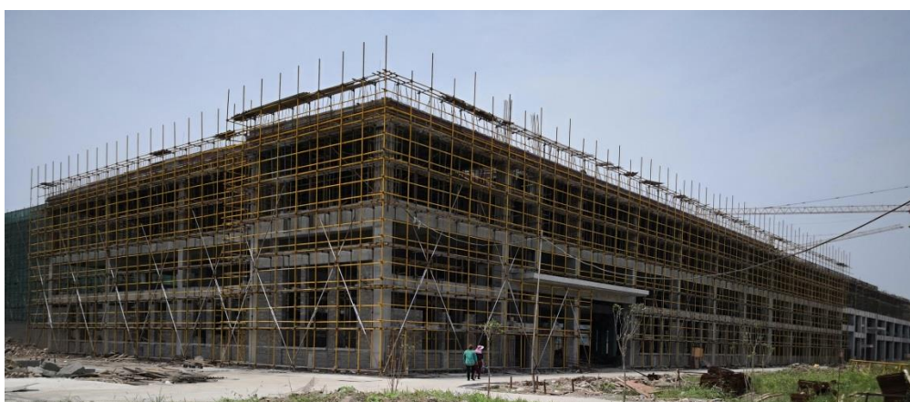
建设中的 1#车间
