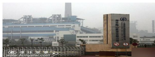
上海（南京）梅山钢铁股份有限公司配电工程
