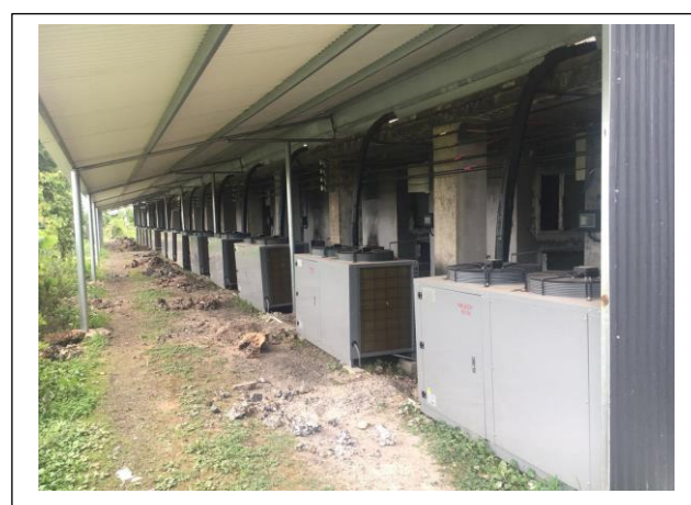
2018 年 6 月公司安装的贵州项目施工现场
