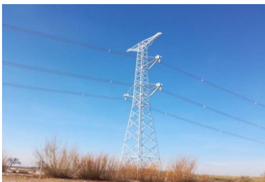
公司特高压交流 1,000kV 复合横担塔应用于锡盟-胜利输电工程
