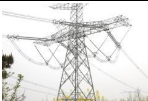
公司线路复合绝缘子在±800kV“锦屏-苏南”特高压直流耐张塔的应用情况
