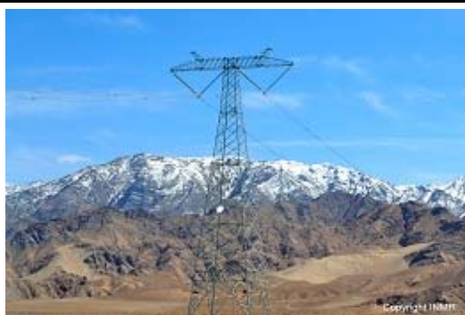
公司线路复合绝缘子在±400kV格尔木-拉萨直流输电工程的应用情况
