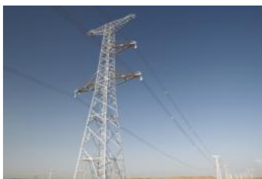
公司复合横担在新疆哈密750kV输电线路的应用情况
