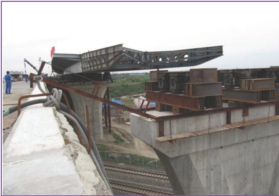
图 7-3-12 跨线桥（钢箱梁顶推）施工示意图
