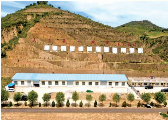
神东煤炭集团扶持吴堡县手工挂面厂建设
