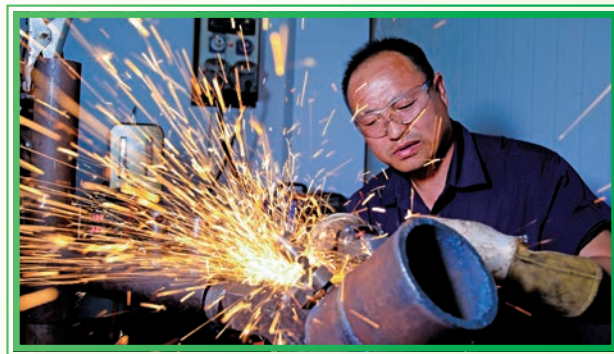
焊工技能大师演示组对管道环缝焊接
