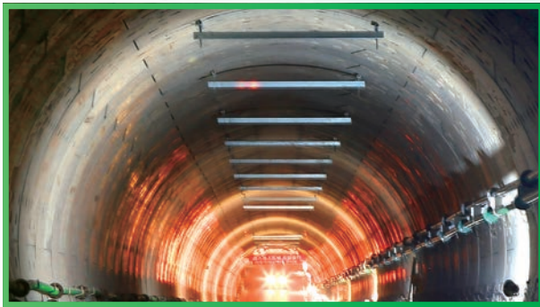
国内首座TBM长距离大坡度煤矿斜井施工
