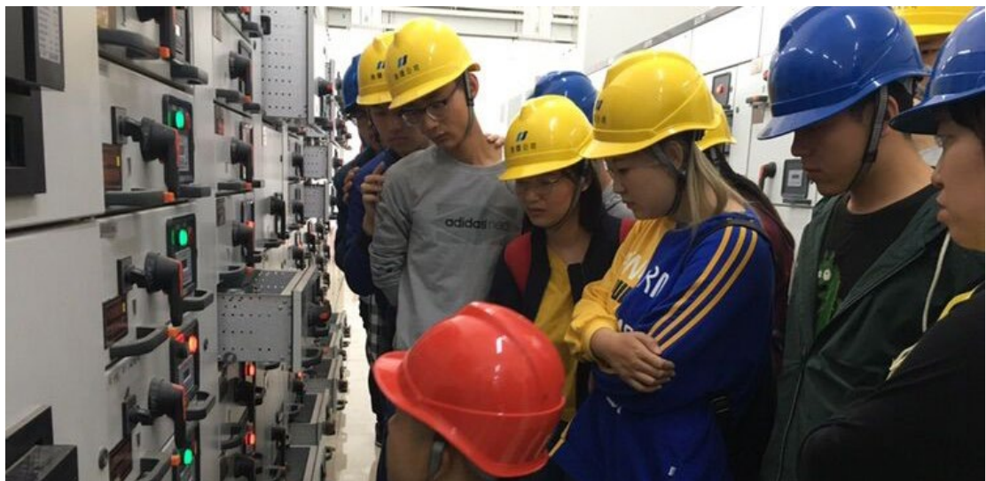
>>> 天津华电南疆热电有限公司（“天津南疆公司”）组织员工进行现场培训
