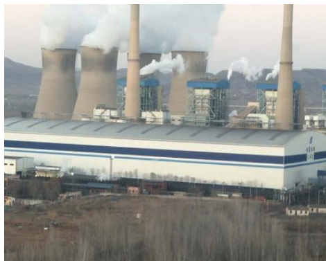
>>> 华电国际莱城发电厂煤场扬尘治理内部工程全部结束
