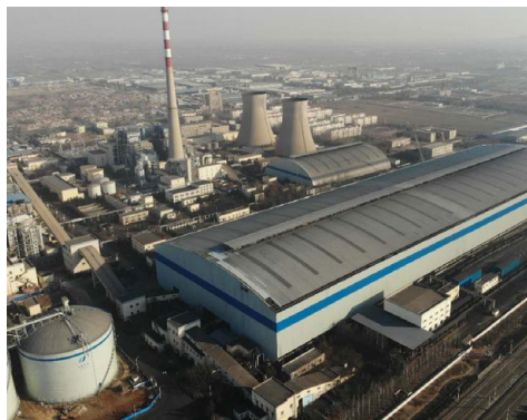
>>> 华电章丘发电有限公司（“章丘公司”）扬尘治理改造项目 1,2 号煤场主体封闭已完成
