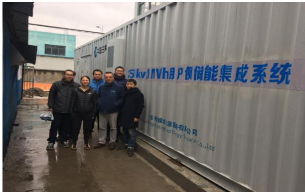
公司承建的首个用户侧储能项目-启东螺丝厂 250KW/1MWh 项目于 2018 年 12 月 25 日正式投运，交付三峡电能运营。
