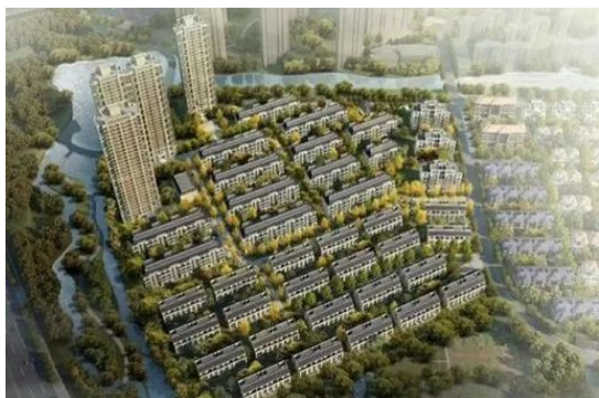
世茂地产暨阳湖苑配电工程
