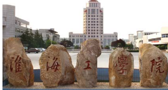
淮海工学院配电工程施工和设施安装项目
