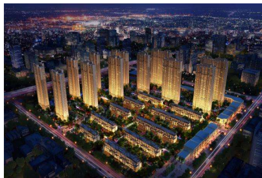
路劲地产城市印象三期配电工程
