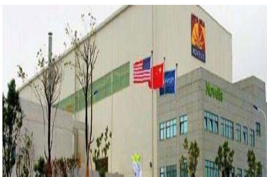
诺贝丽斯（中国）35/20kV 变电站工程
