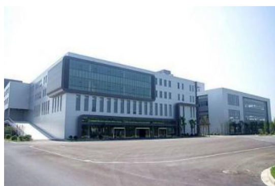
车和进标准厂房 10kV 变电所工程
