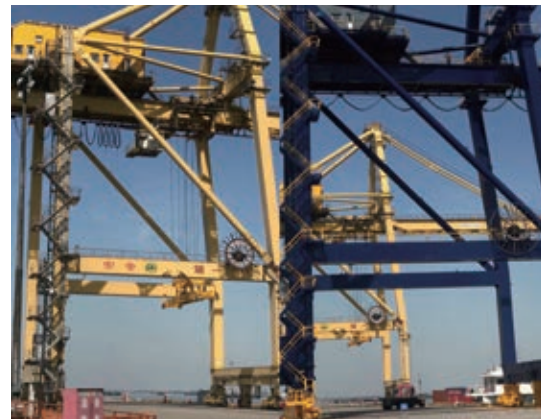
除銹刷新前後的集裝箱岸邊起重機
