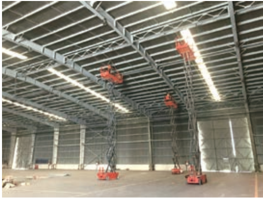
新消防系統 – 安裝空氣採樣系統、排阻燃管
