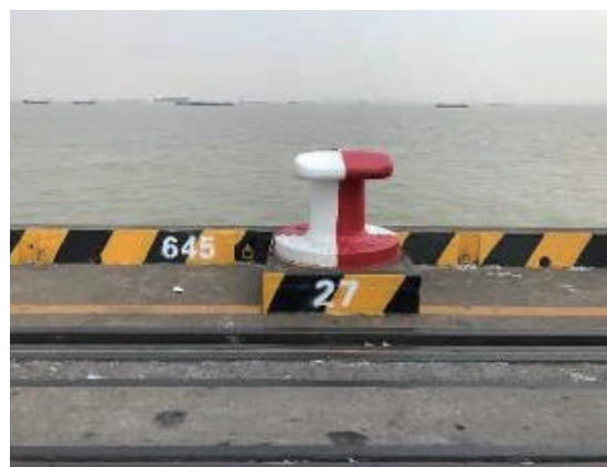
系纜柱 — 除銹刷新後
