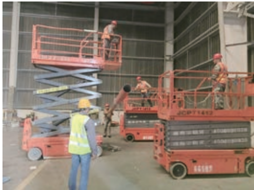
新消防系統 – 安裝消防水龍管
