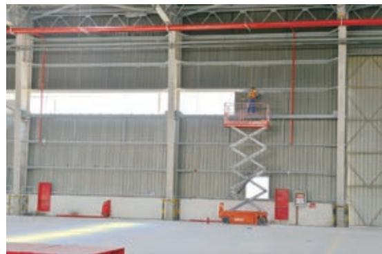
新消防系統 – 耐火塗料
