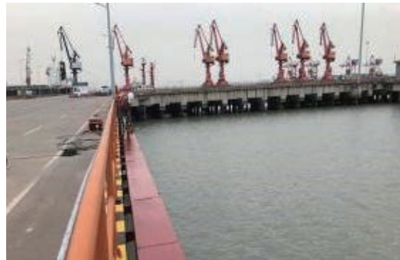
欄杆 — 除銹刷新後
