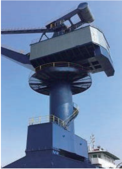
除銹刷新後的門座起重機
