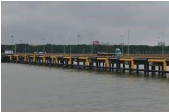
欄杆 — 除銹刷新後
