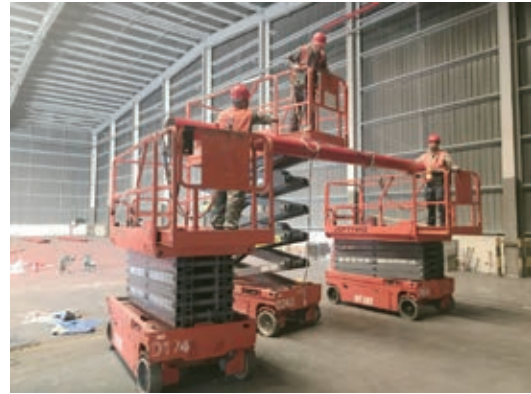
新消防系統 – 安裝消防水龍管
