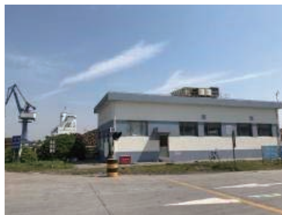
供電室 — 除銹刷新後
