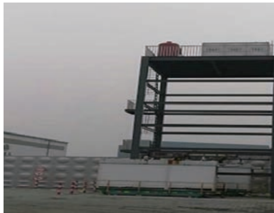
新消防系統 — 水箱及水泵
