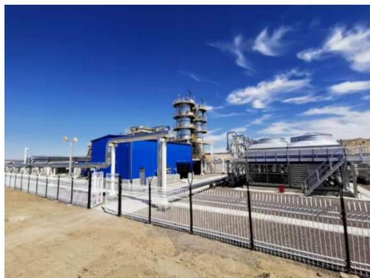
风城油田密闭集输外排废汽回收处理项目，为了回收处理外排含油蒸汽，敦华石油通过近 3 年的调查研究，研发出具有自主知识产权适用于油田含油蒸汽的处理工艺（喷淋+油水分离+闭式冷却）。建设密闭集输外排废汽回收处理站，示范工程于 2015 年 12 月投产运行，达到预期目标，满足现场要求。2019 年再次建设完成六套装置，投入使用。
