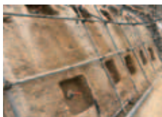
土釘鑽孔及安裝
