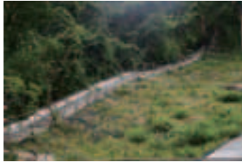
建造混凝土維修樓梯／通道
