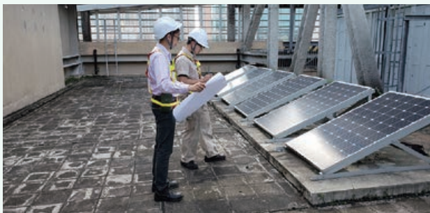
於朗豪坊商場天台安裝太陽能光伏板
