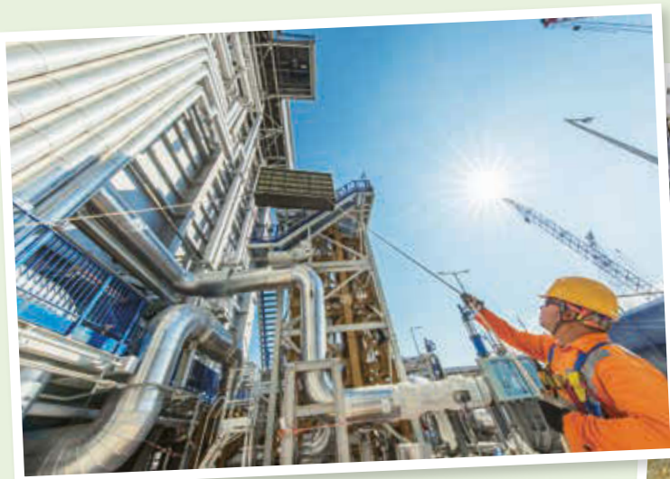
▲ 工程人員正安裝「選擇性催化還原脫硝系統」。
