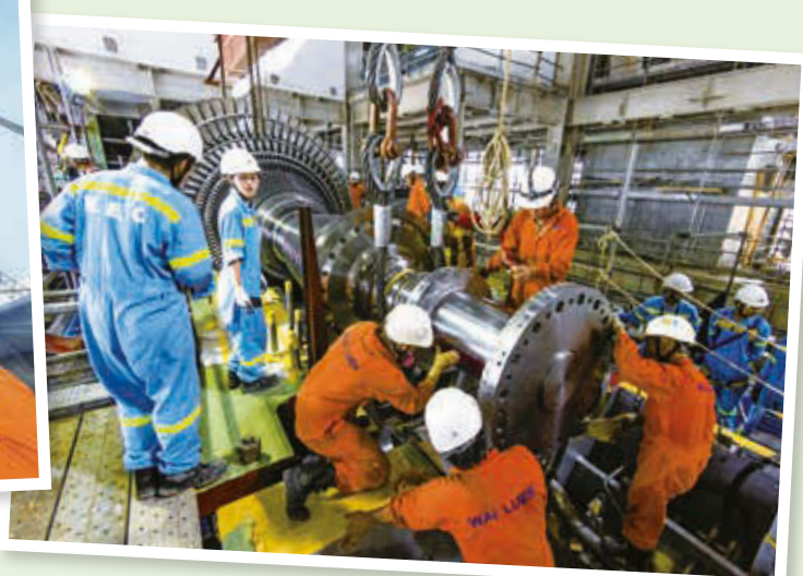
▲ 工程人員正忙於組裝 L10 機組的汽輪機。
