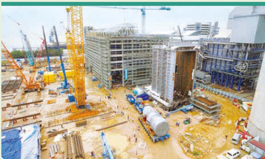
▲ 由於南丫發電廠工地空間有限，很多組件均預先在工地以外的地方裝嵌，以確保不影響工程進度。
