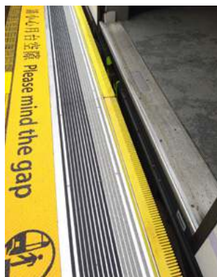
在豐景園站安裝並 試行易達斜台
