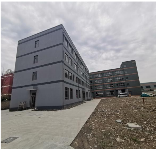
5#6#厂房于 2019 年 12 月底建造完成。
