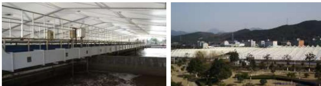
污水处理厂废气收集管路与反应池体密闭加盖示意图
