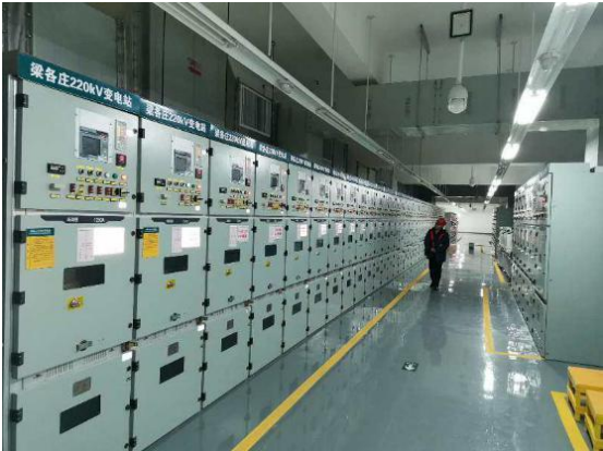
输变电工程高压开关柜
