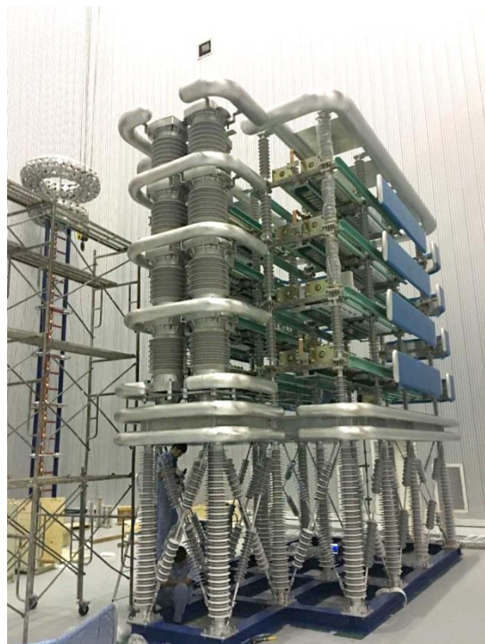
200kV 直流断路器用避雷器--舟山柔直工程
