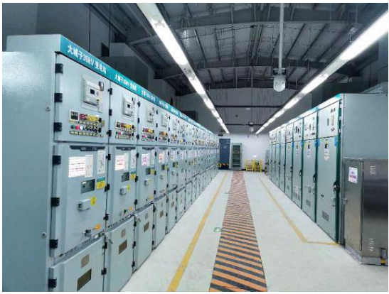
输变电工程高压开关柜
