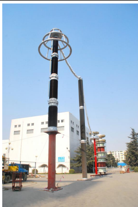
1000kV 特高压避雷器电位分布试验
