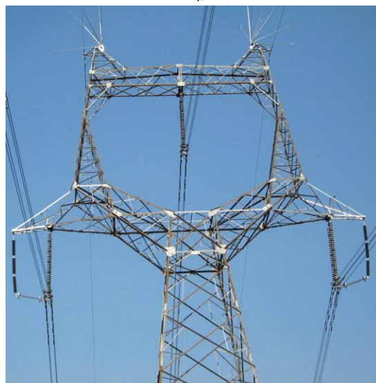
500kV 线路型避雷器
