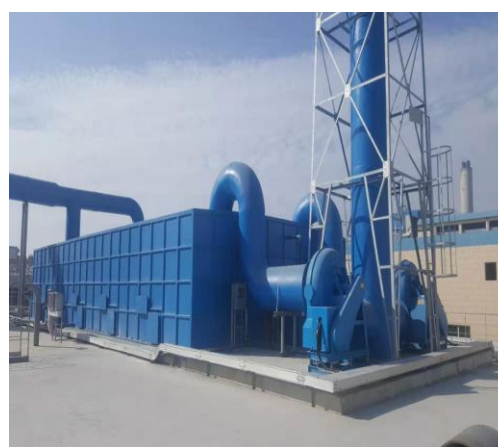
2019年9月，公司完成玖龙纸业(泉州)基地污水处理厂废气除臭项目
