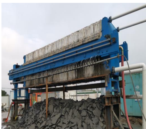
2019年，公司完成启东市水环境综合整治工程PPP项目
