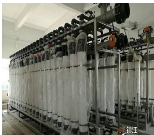
2019年上半年，公司完成江苏索普(集团)有限公司中水回用处理系统工程
