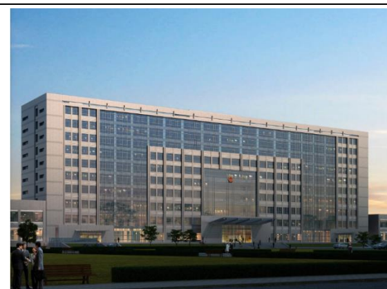
新疆克拉玛依市行政综合楼
