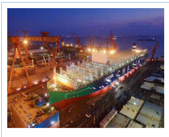
2019年度亚达为沪东中华&江南造船建造的23000TEU系列集装箱船的LNG加注、透气、燃气输送系统提供设计、制造、安装一站式服务
