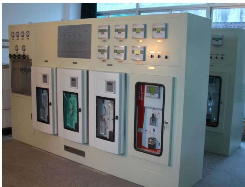
水汽取样系统示意图
