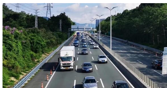
广深高速深圳段路灯项目
