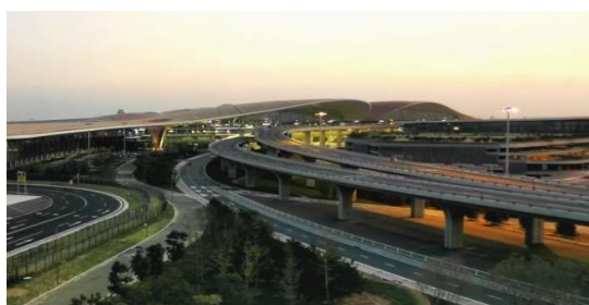
北京大兴国际机场路灯项目
