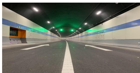
湖南常德沅江隧道工程项目
