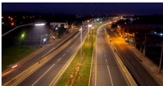
巴拉圭 Ruta 3 号路路灯项目
