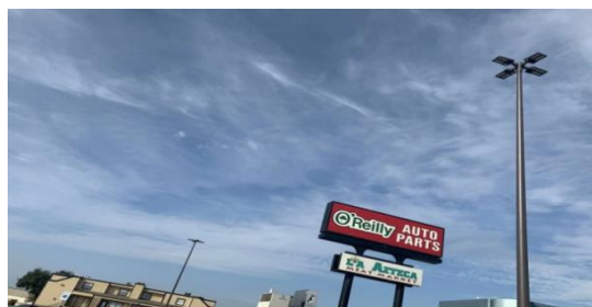
美国 O'Reilly 汽车停车场高杆灯项目
