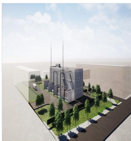
南京滨江LG化学220kV变电站工程
