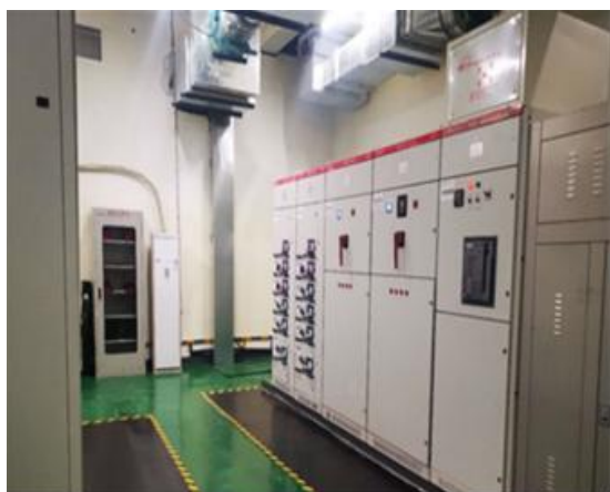
延安吾悦广场大商业项目
