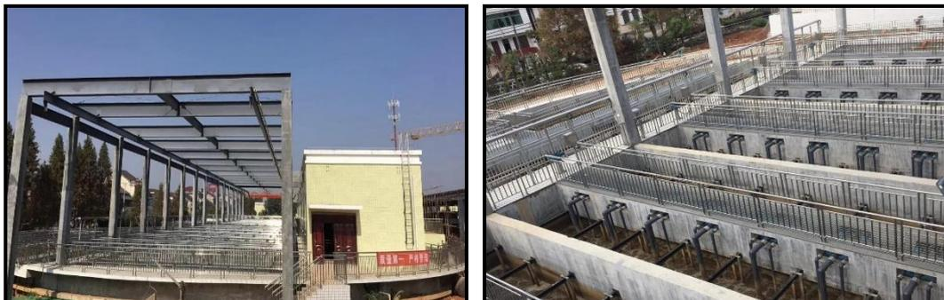
该污水处理厂原出水标准为《城镇污水处理厂污染物排放标准》（GB18918-2002）一级 B 标准，该项目在原污水厂内不新增占地的情况下，把二沉池改造成 MBR 膜池及膜设备间，主体工艺采用“厌氧/缺氧/好氧工艺+MBR 工艺”。改造后，污水处理厂日处理量由 10 万  $m^3/d$  扩容至 16 万  $m^3/d$ ，出水标准提升至（GB18918-2002）中的准一级 A 标准。
