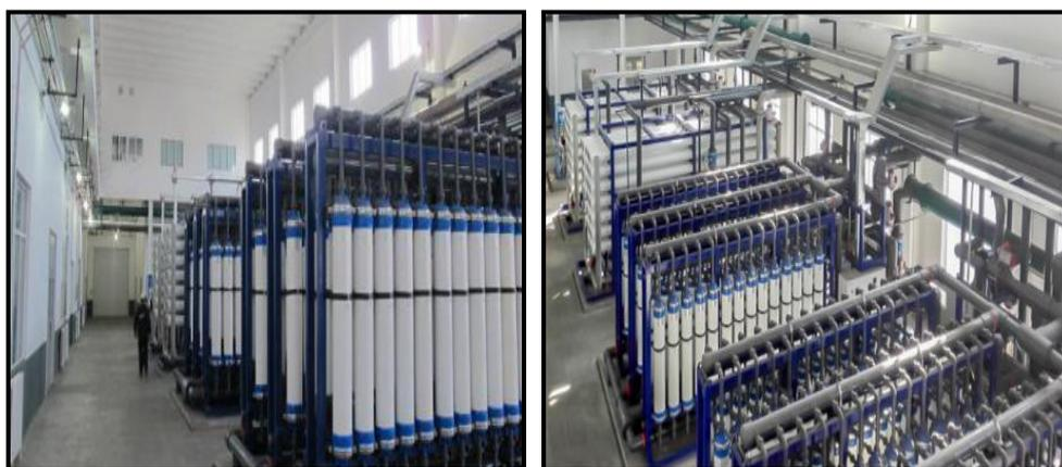
该项目采用“超滤+反渗透”相结合的工艺，项目分两期建设，第一期处理水量为 8,500m<sup>3</sup>/d，第二期处理水量为 12,000m<sup>3</sup>/d，系统回收率大于 85%，处理后的高品质回用水用于循环水和锅炉补给水。
