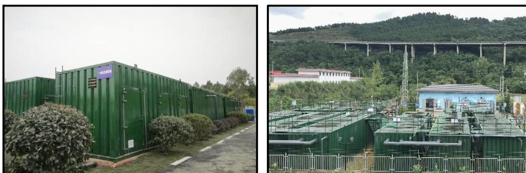
该项目系针对四川成都国际空港新城高新区 12 个乡镇的生活污水提标、改造项目，共设置分散式污水处理设备 14 套，主体工艺采用“生物强化工艺+MBR 工艺”，出水水质稳定达到《四川省岷江、沱江流域水污染排放标准》DB51/2311-2016。
