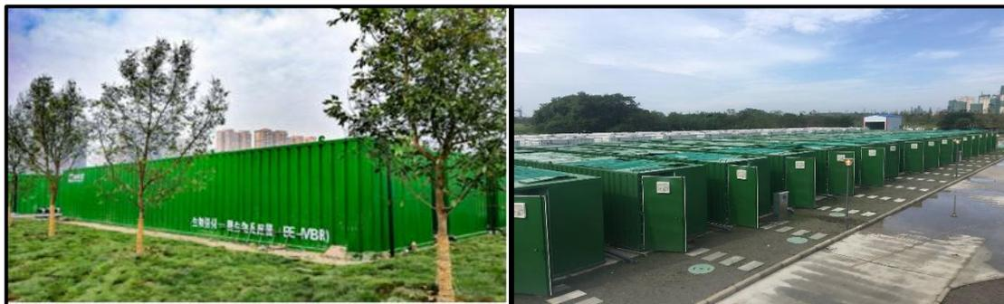
该项目共设置分散式污水处理设备 65 套，分散式污水处理设备主体工艺采用“生物强化工艺+MBR 工艺”，出水水质稳定达到《城镇污水处理厂污染物排放标准》（GB18918-2002）中的一级 A 标准。
