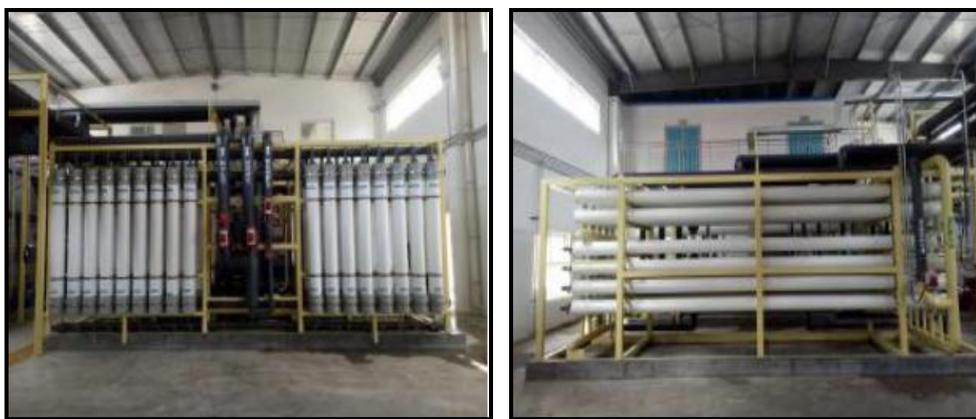
该项目原水为太阳纸业前端污水厂处理后排放水，系统整体布局按产水规模 20,000m<sup>3</sup>d 进行规划设计和预留。一期项目产水 5,000m<sup>3</sup>d，回用工艺为“预处理+超滤+反渗透”，系统回收率大于 70%，产水车间回用。项目主要运行参数如下表：
