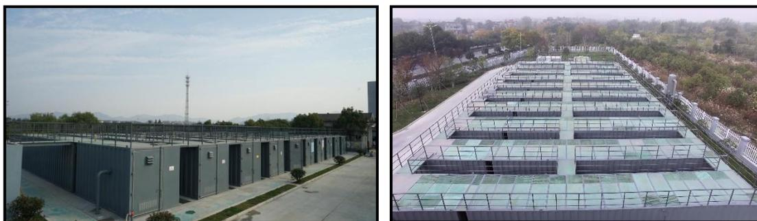
该项目共设置分散式污水处理设备 20 套，单套处理规模 500m<sup>3</sup>/d，总处理规模 10,000m<sup>3</sup>/d，设备主体工艺采用“生物强化工艺+MBR 工艺”。出水水质稳定达到《城镇污水处理厂污染物排放标准》(GB18918-2002)中的准一级 A 标准。
