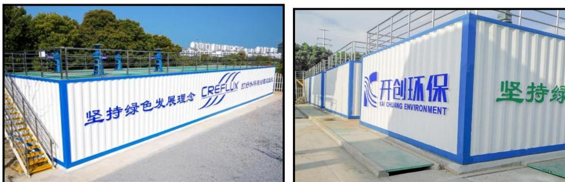
该项目共设置分散式污水处理设备 20 套，单套处理规模 500m<sup>3</sup>/d，总处理规模 10,000m<sup>3</sup>/d。分散式污水处理设备主体工艺采用“生物强化工艺+强化脱氮工艺+MBR 工艺”，出水水质稳定达到类地表水 IV 类水质标准。
