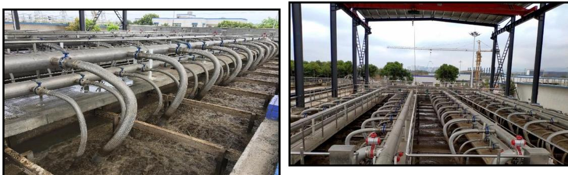
该污水处理厂处理总规模 40,000.00  $m^3/d$ ，出水标准为一级 A 标准。该改造项目不新增占地，把一期平流沉淀池改造成 MBR 膜池，新建膜设备间，实现一期提标扩容；同时，把二期生化池改造成 MBR 膜池，新建膜设备间，实现二期提标扩容。该项目采用“预处理+膜格栅+厌氧/缺氧/好氧工艺+MBR 工艺+接触消毒工艺”，出水水质提升至准 IV 类水质标准。
