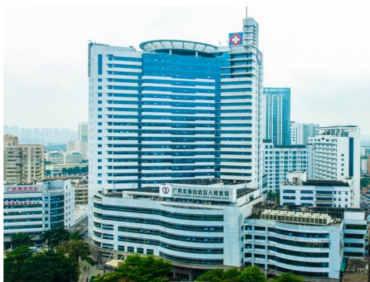
广西区人民医院门诊综合楼 (2005 年度部级优秀勘察设计三等奖)
