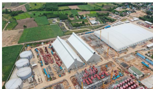
泰国 KSP 糖厂及发电厂建设项目(日处理甘蔗 24000 吨) (EPC 总承包方为广西建工集团第一安装有限公司)
