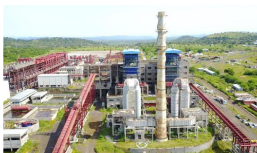
埃塞俄比亚 BELES-1 号 12000TCD 糖厂续建项目(日处理甘蔗 12000 吨) (EPC 总承包方为中工国际工程股份有限公司)
