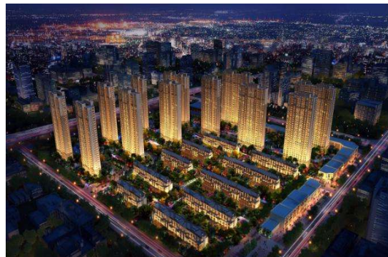
路劲地产城市印象三期配电工程
