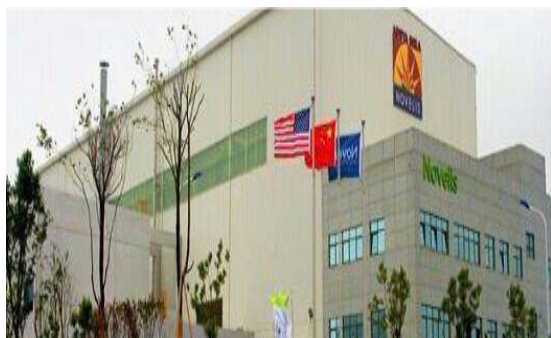
诺贝丽斯（中国）35/20kV 变电站工程
