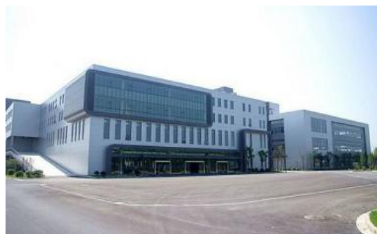
车和进标准厂房 10kV 变电所工程
