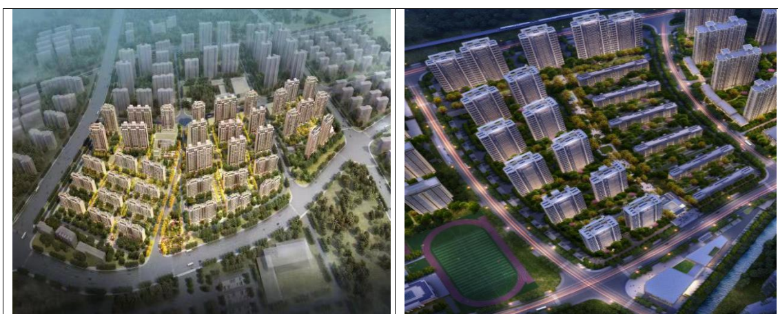
中海地产—中海润泽园项目
