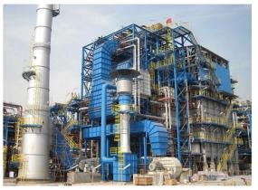
转化炉是一种非常特殊的外热式列管反应器,由于转化反应的强吸热及高温等特点,这种反应器被设计成加热炉的形式,催化剂装在一根根的转化炉管内,在炉膛内直接加热,反应介质通过炉管内的催化剂床层进行反应。转化炉苛刻的操作条件,使得转化炉有很多有别于其它加热炉的特殊性,在炉体结构、炉管材料、管路系统支撑、管路系统应力、管路系统膨胀及补偿、燃烧、烟气流动及分配、耐火材料等各方面都必须精心考虑。
