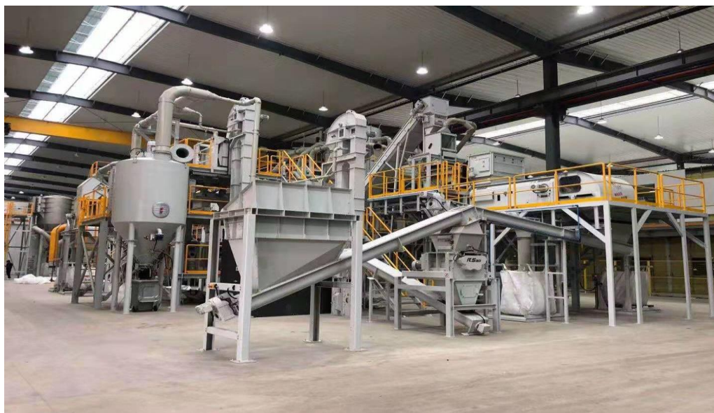
废电冰箱拆解线
