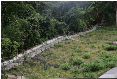
建造混凝土維護樓梯／通道
