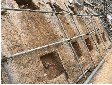
土釘鑽孔及安裝
