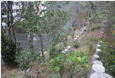
安裝防護泥石流的剛性防護網
