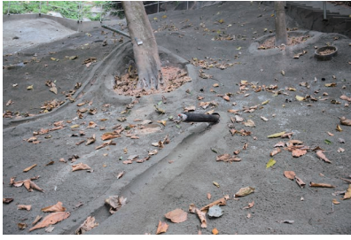
安裝排水斜管
